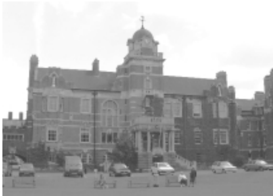
Conference の主な催しが行われた Pembroke House, Medway Campus, U of Greenwich (元々は海軍が使っていた建物だそうです。Medway 構内にあるパブの名が“The Drunken Sailor”。宮丸裕二)
